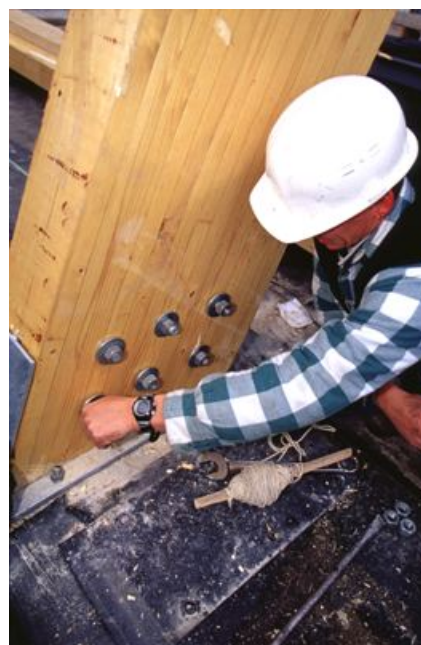
6 boulons de 16 mm de diamètre assurent la fixation de l'arc
