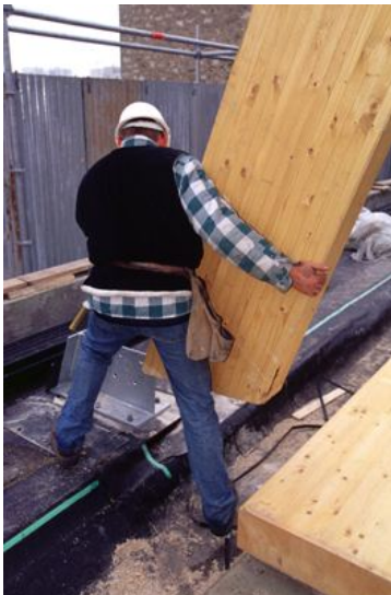
Insertion du pied d'arc dans la ferrure
